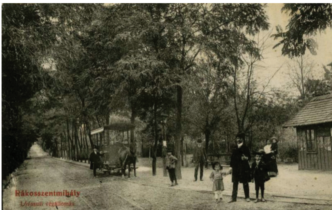
12. kép: Lóvasút végállomás.
